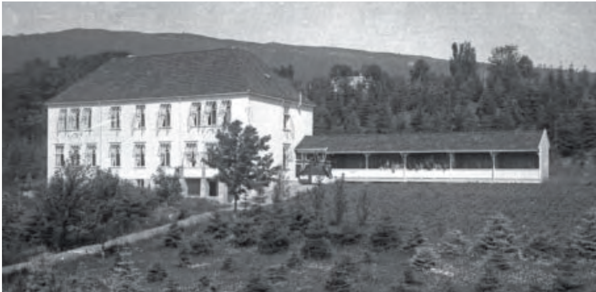
Barnesanatoriet, Reknes, Molde, ca 1920. Reknes Sanatorium for tuberkulose var Norges første statlig drevne sanatorium og ble opprettet i 1896 som et såkalt tæringshospital, med 72 senger i de nyeste bygningene til det tidligere leprahospitalet. Sanatoriet var i drift frem til 1960 da det nye Fylkessjukehuset i Molde åpnet og lungeavdelingen der overtok pasientene.
